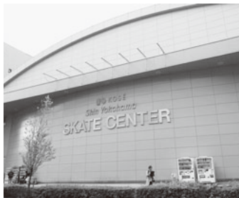
KOSÉ新横浜スケートセンター正面
