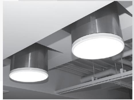
本社の照明設備には、太陽光を鏡で複雑反射させた自然光照明を採用しています
