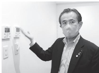
会議室には、地下水を熱源とするヒートポンプマルチエアコンと、電気を使用するエアコンの2つの壁付けリモコンが設置されています
